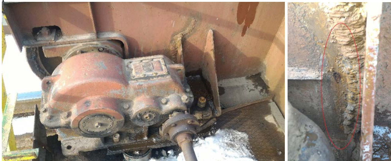
Рисунок 1 – Тріщина вертикальної стінки кінцевої балки
