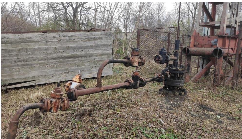
Рис. 1. Свердловина №2000 з від'єднаним шлейфом
